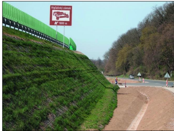
Vystužený svah po aplikácii hydroosevu- rýchlostná cesta R2 Pstruša - Kriváň
