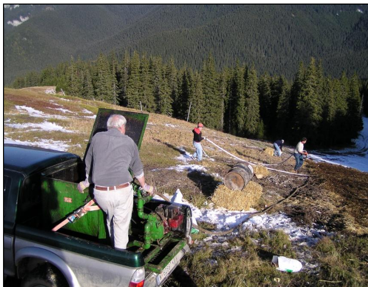
Hydrosev so slamou použitý pri úprave zjazdovky v NP Malá Fatra
