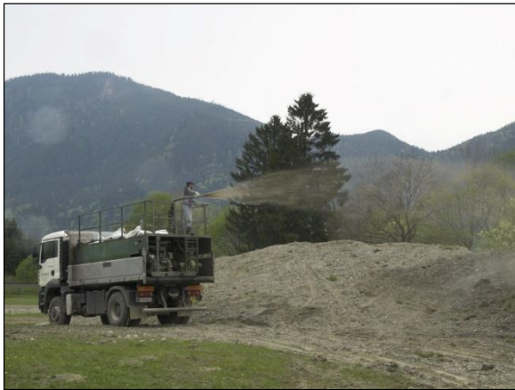
Jednoduchý hydrosev pri obnove brehu rieky (foto B. Krautzer)
