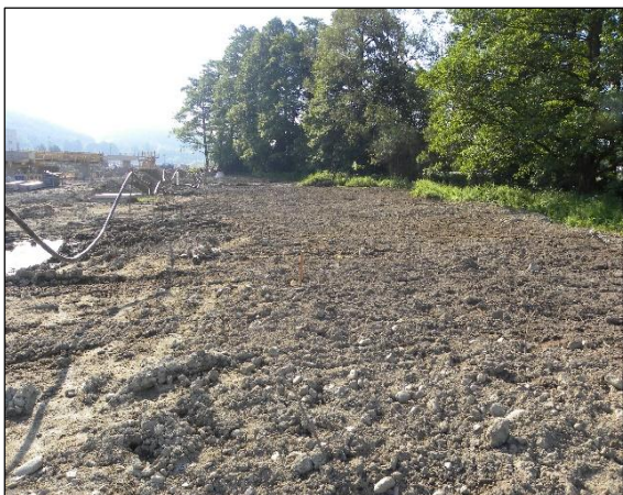
Úprava povrchu pred zatrávnením
